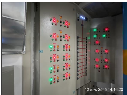
ภาพที่ 8 ระบบมอเตอร์ไฟฟ้าสำหรับระบบบำบัดน้ำเสีย
