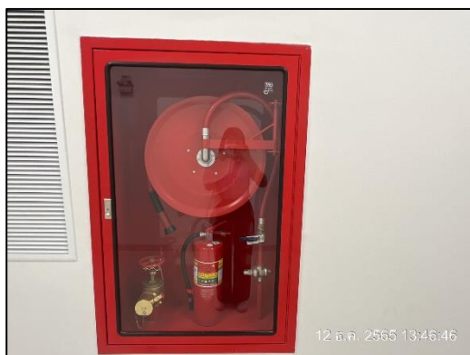
ภาพที่ 33 ตู้เก็บสายฉีดน้ำดับเพลิง
