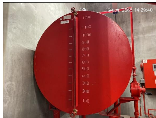
ภาพที่ 18 ถังสำรองน้ำดับเพลิง
