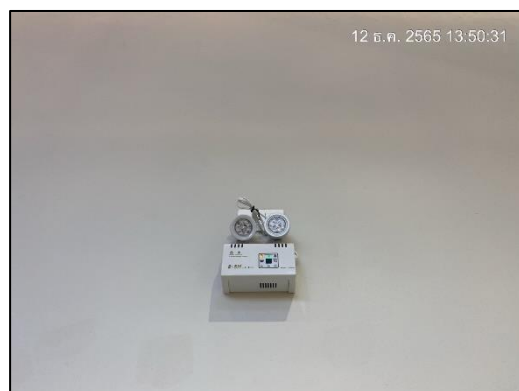
ภาพที่ 24 ระบบไฟฟ้าฉุกเฉิน
